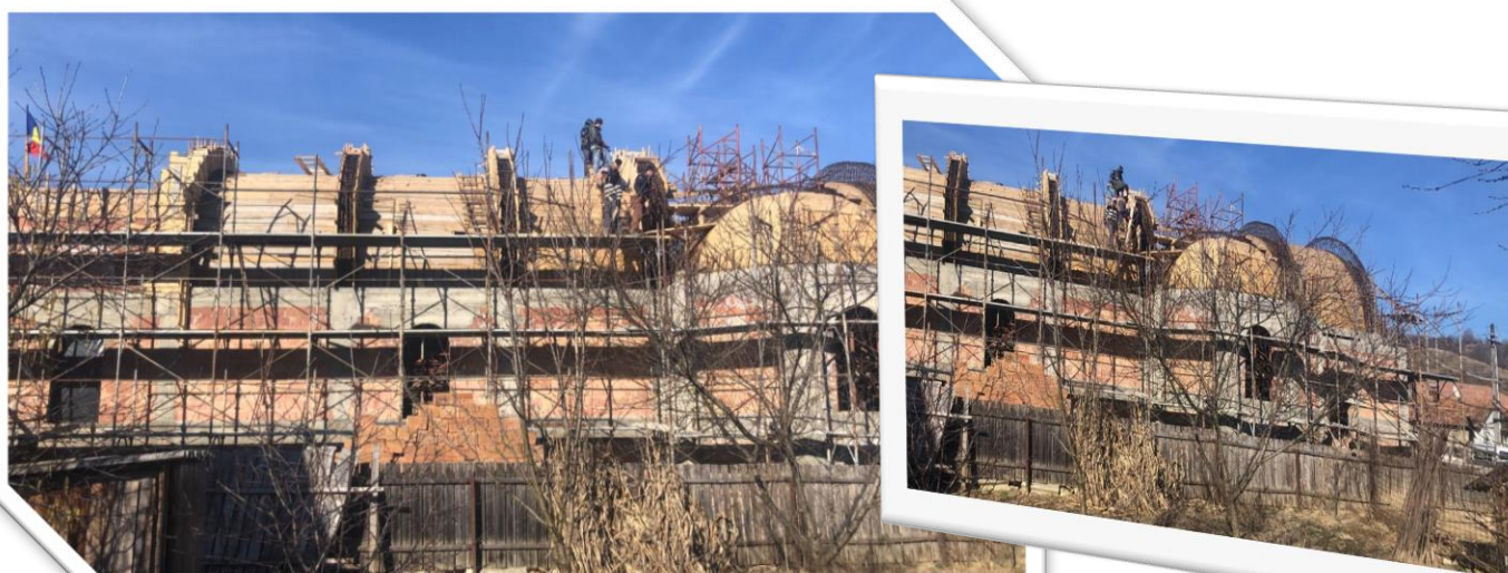
Biserică în construcție – Sat Curița
