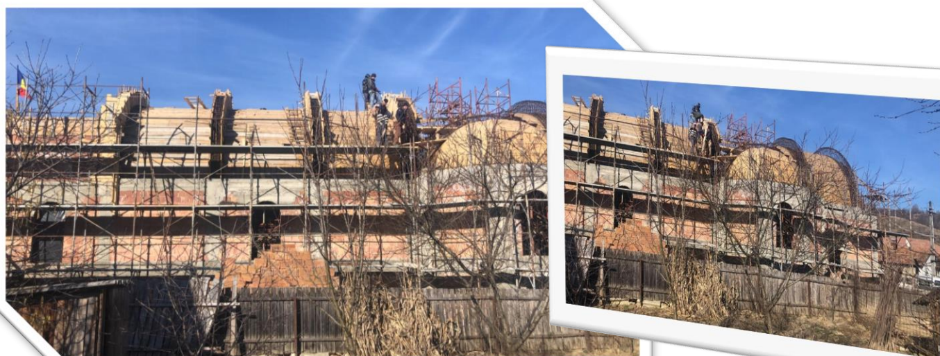
Biserică în construcție – Sat Curița
